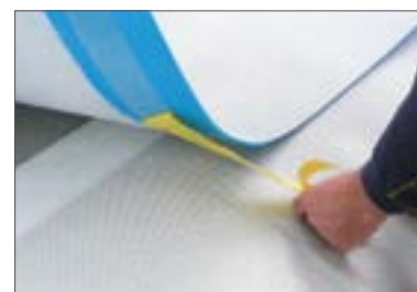
(2) Ta bort det gula skyddande bandet för att fixera sidoskiktet
