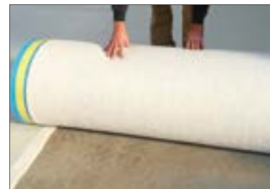
(1) Rulla ut underlaget med överlappningen över sidovalsens
