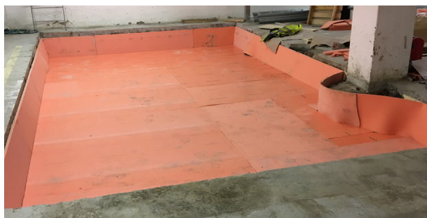
Norrköping, Yllefabriken (2017) Kylaggregat
